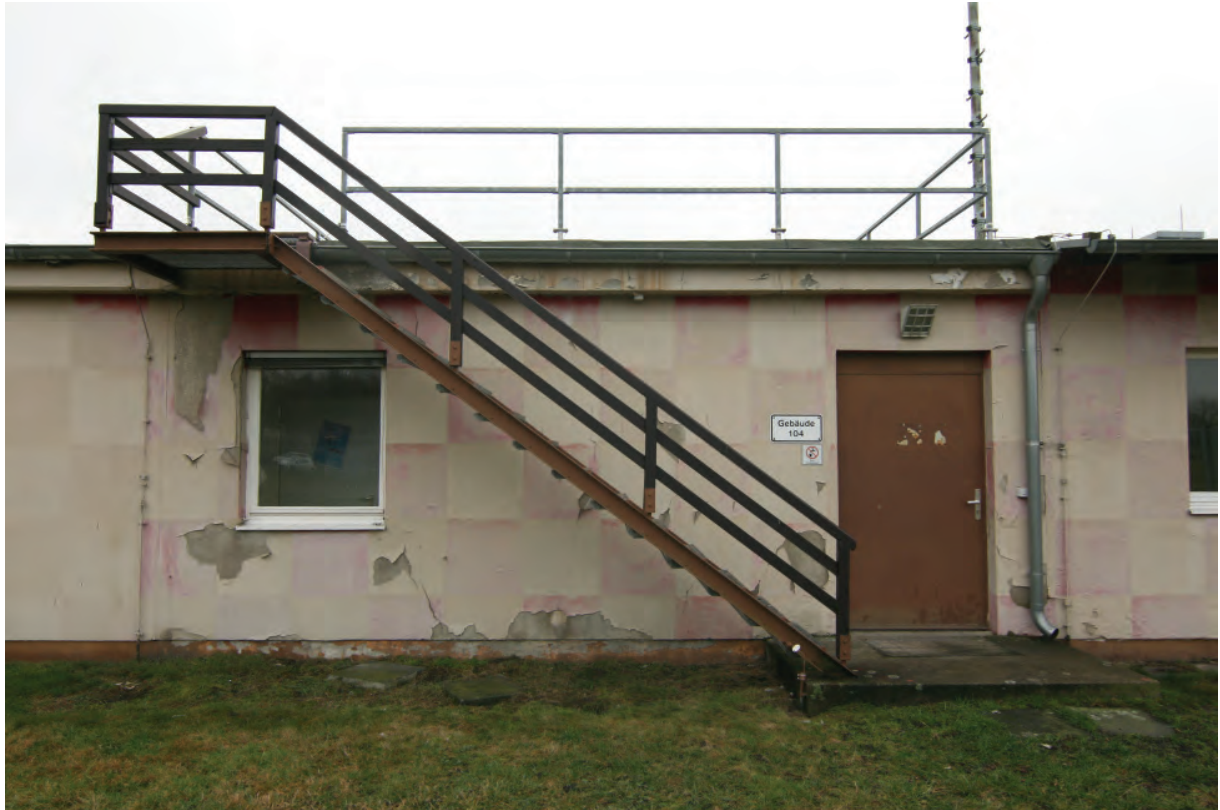
1. Erweiterung um 1972. Eingang TA 2, Stahltreppe zur Dachterrasse.
