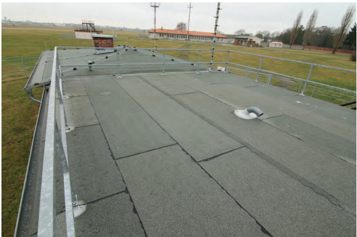
1. Erweiterung um 1972, Dachterrasse. Im Hintergrund Dach Kernbau.
