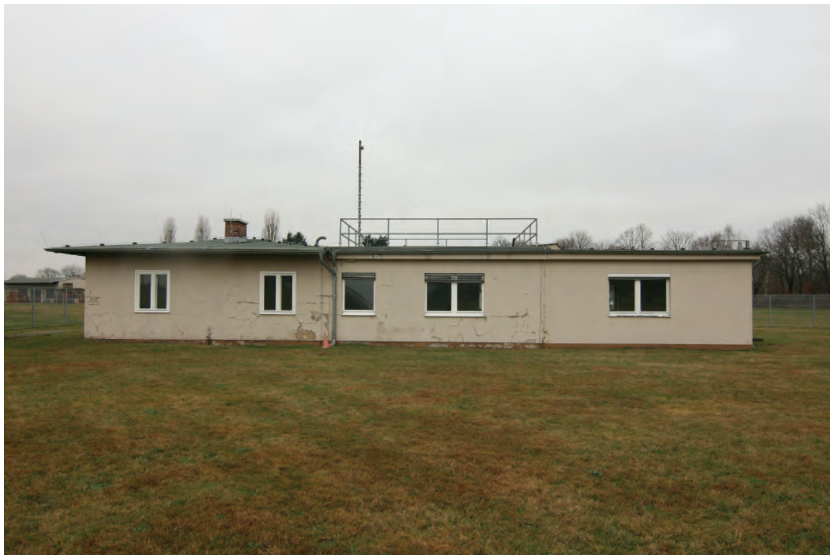
Südostseite, links Kernbau von 1940.
