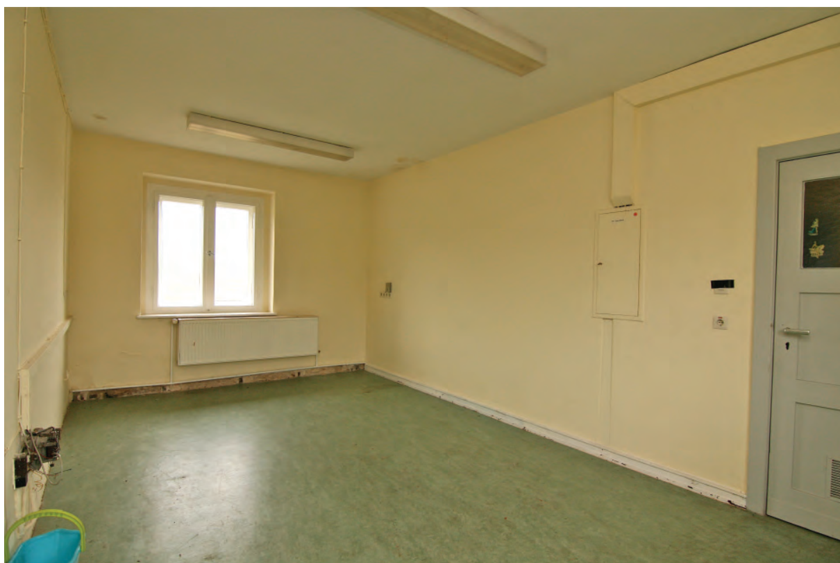
Kernbau von 1940. Raum 4, Blick auf Fenster F 1.9, rechts Tür TI 1.4.
