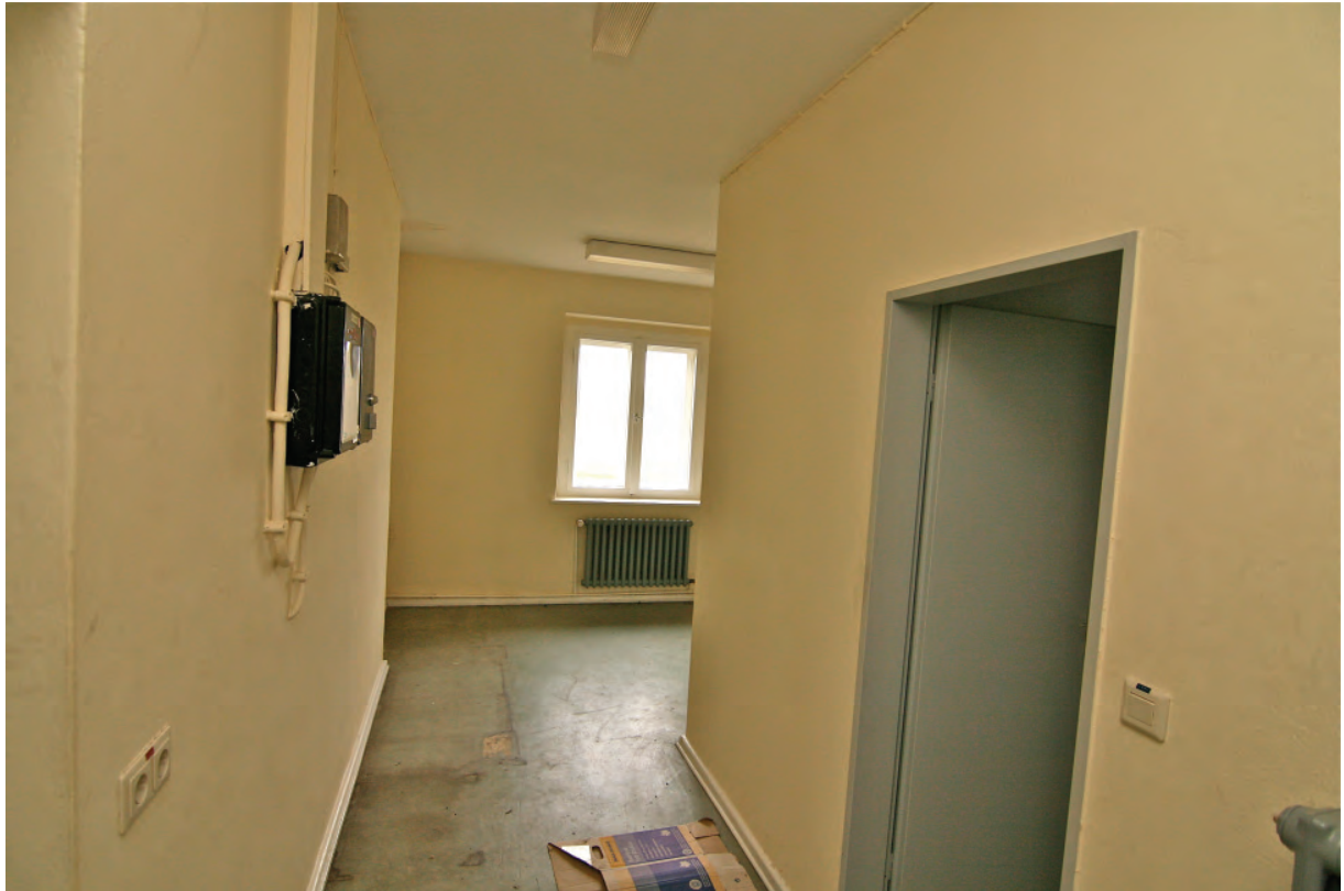
Kernbau von 1940. Raum 5, Blick vom Eingang TA 1.
